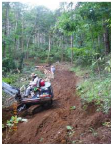
2010.8～ 作業路の開設作業
